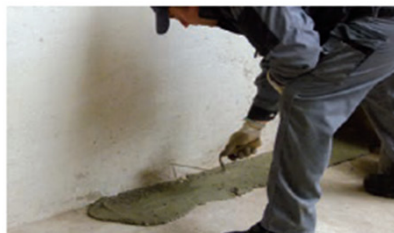
Realizzazione del piano di posa a livello per il primo corso di blocchi
