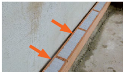
Intercapedine di almeno 2 cm tra Porotherm Revolution e parete esistente
