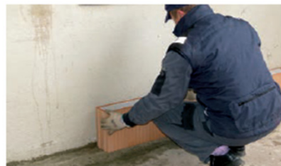
Applicazione del primo corso di Porotherm Revolution
