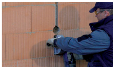
Realizzazione delle tracce con opportuno scanalatore
