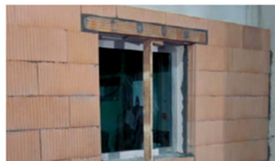
Completamento della parete isolata
