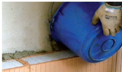
Riempimento dell'intercapedine con malta di allestimento
