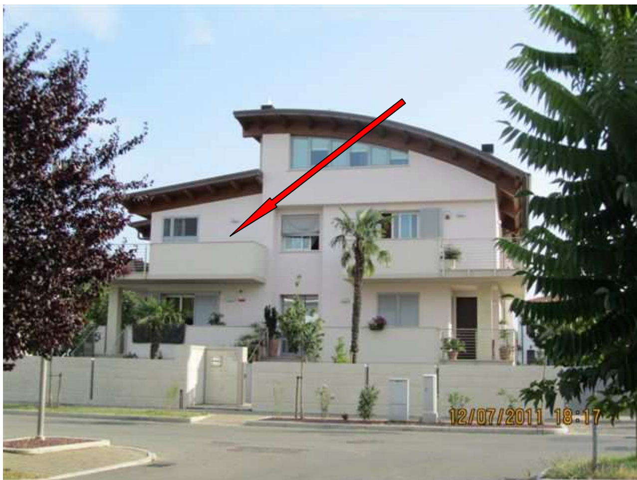
Immagine 1: Veduta complessiva della parete Nord dell'edificio in esame con evidenziata la posizione delle sonde (piano primo, stanza da letto matrimoniale).
