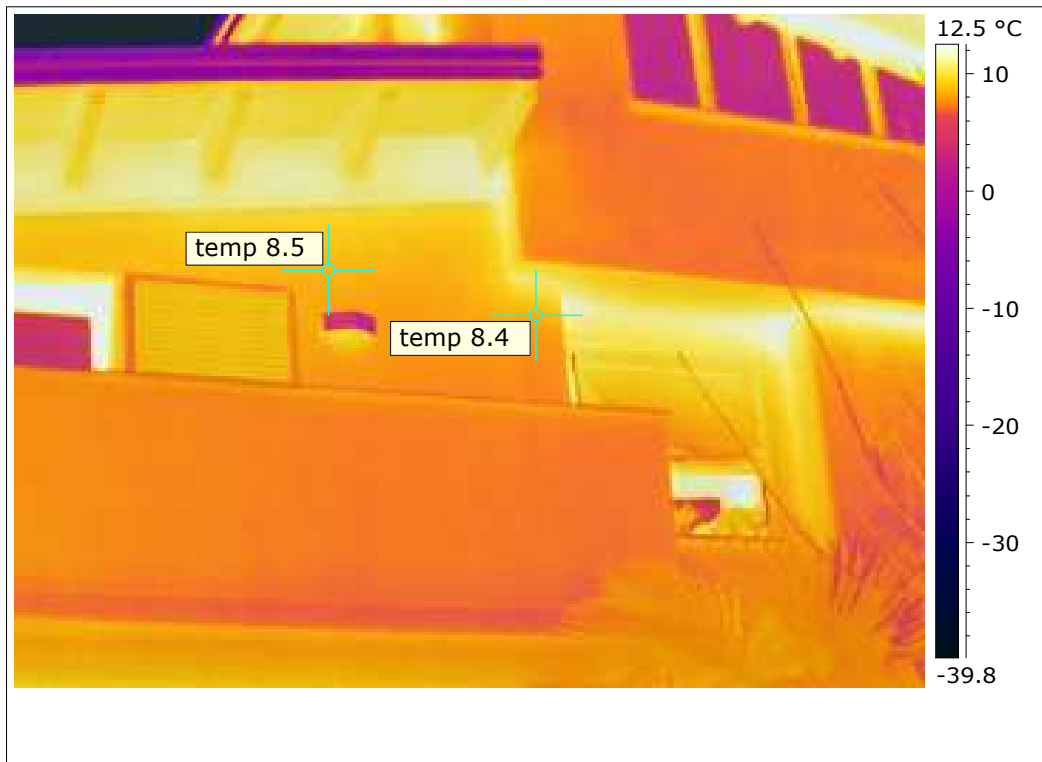
Immagine 6: Veduta esterna lato Nord – Piano primo
