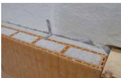
Realizzazione dell'ancoraggio della controparete alla parete esistente ogni 3 corsi in altezza a distanza orizzontale di 1,5 m*
