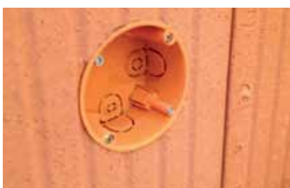
Installazione delle scatole di derivazione per l'impianto elettrico
