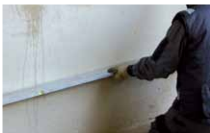
Controllo della superficie: planarità, verifica dell'aderenza dell'intonaco, etc.
