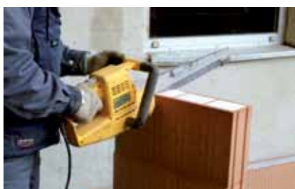
Taglio dei blocchi con apposita sega (seghe a nastro o a disco con lama per laterizio)
