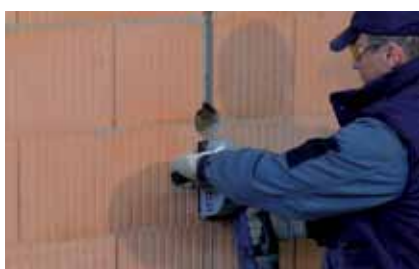
Realizzazione delle tracce con opportuno scanalatore
