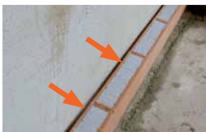
Intercapedine di almeno 2 cm tra PoroTherm Revolution e parete esistente
