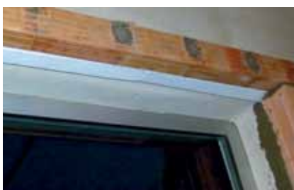
Realizzazione architravatura classica con fondello in laterizio di lunghezza adeguata e isolante interposto
