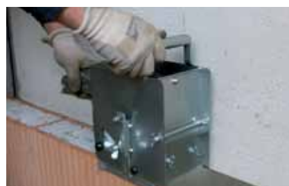
Applicazione della malta speciale con il rullo stendi malta
