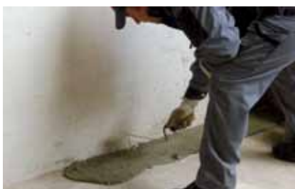
Realizzazione del piano di posa a livello per il primo corso di blocchi
