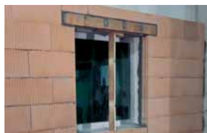
Completamento della parete isolata
