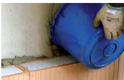
Riempimento dell'intercapedine con malta di allettamento
