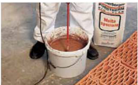
Preparazione della malta speciale
