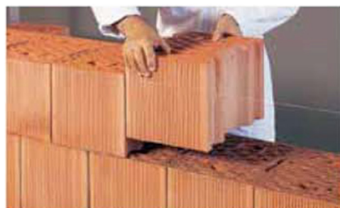
Posa dei blocchi
