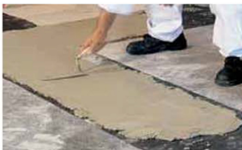
Predisposizione della guaina per l'umidità di risalita
