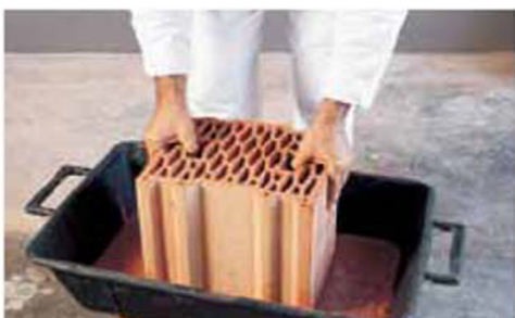
L'applicazione della malta per immersione
