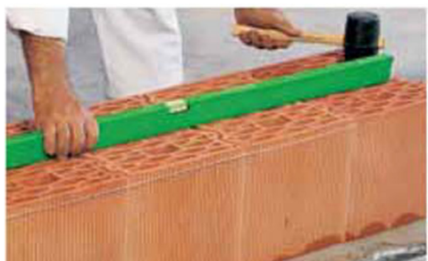
Livellamento del primo corso
