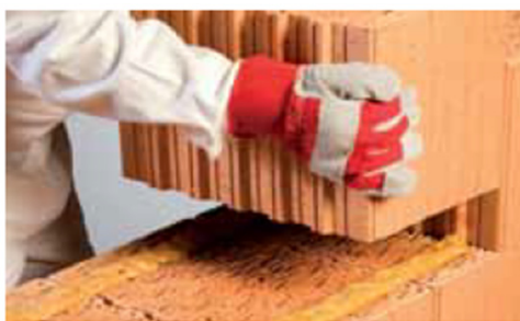
Posa dei blocchi con sistema DRYFIX extra
