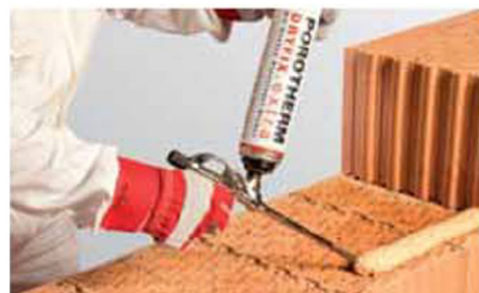
Applicazione schiuma DRYFIX
