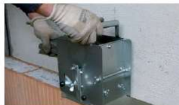
Applicazione della malta speciale con il rullo stendi malta
