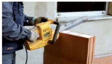
Taglio dei blocchi con apposita sega (seghe a nastro o a disco con lama per laterizio)
