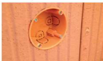
Installazione delle scatole di derivazione per l'impianto elettrico
