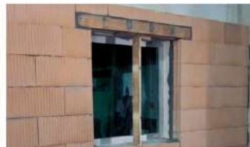
Completamento della parete isolata
