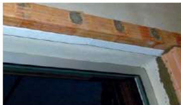
Realizzazione architravatura classica con fondello in laterizio di lunghezza adeguata e isolante interposto
