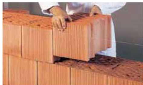
Posa dei blocchi
