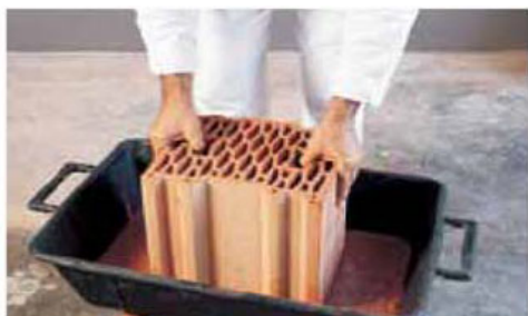
L'applicazione della malta per immersione
