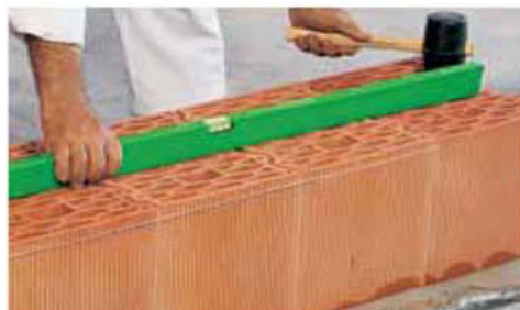
Livellamento del primo corso
