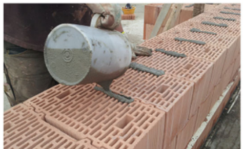
Riempimento delle tasche di malta.
