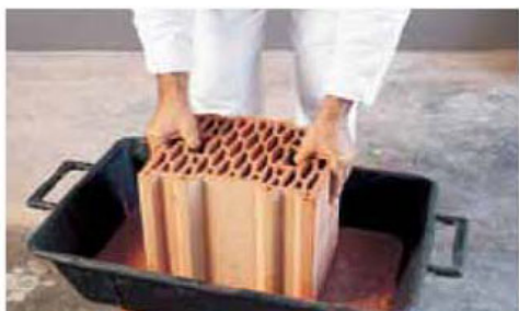
L'applicazione della malta per immersione
